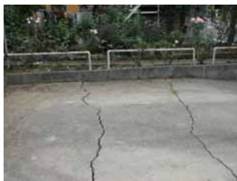
向陽町内の谷埋め盛土地盤内に何列も入る引っ張り亀裂。家屋は外観上大きく傷んでいないが、中は傾いており被害は大きい。
