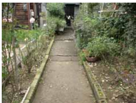
向陽町内の谷埋め盛土地盤内に何列も入る引っ張り亀裂。家屋は外観上大きく傷んでいないが、中は傾いており被害は大きい。
